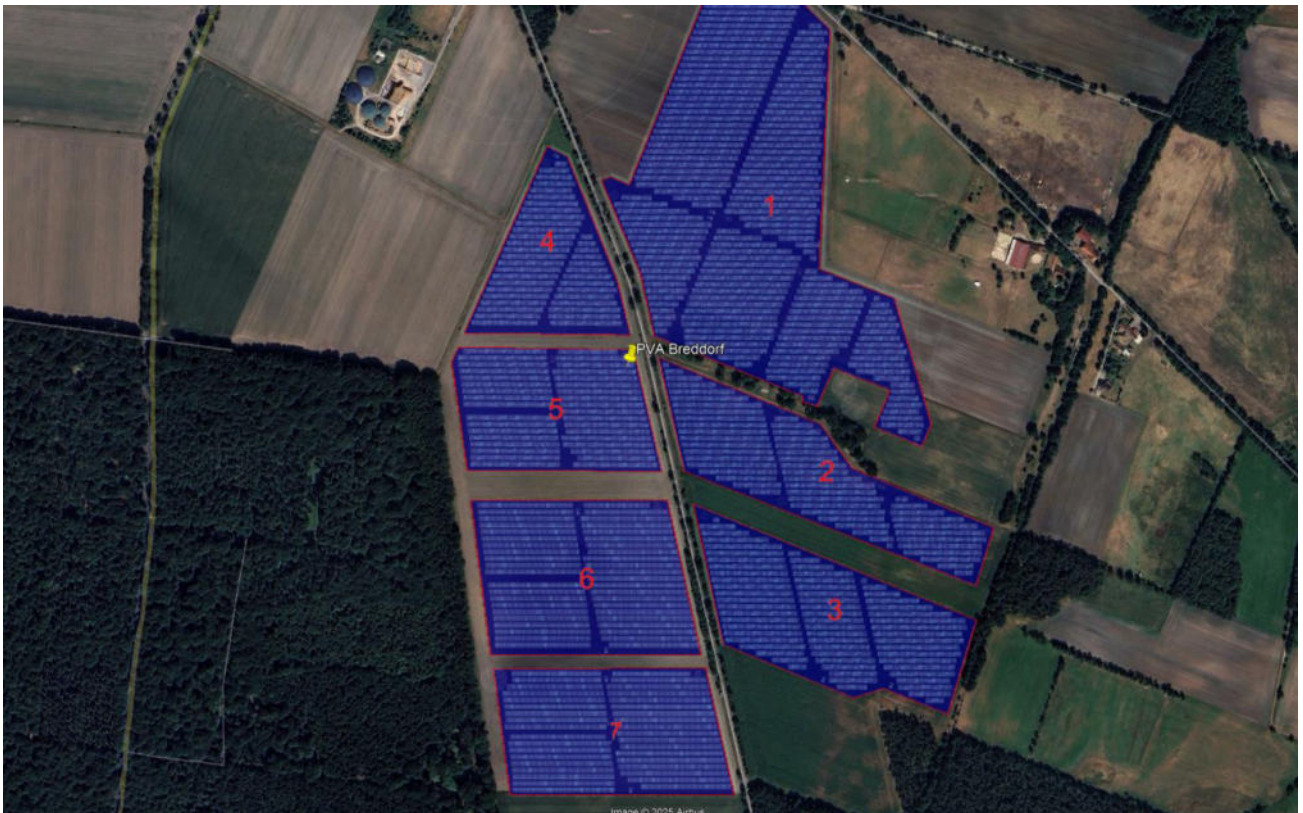
Bild 2.1.3: Detailansicht der PV-Flächen (Quelle: Google Earth/SolPEG)
